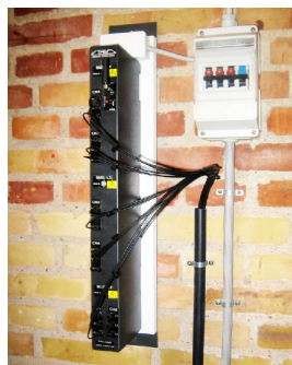
Figur 2.5: SGU Vægmonteret på transformer station.
