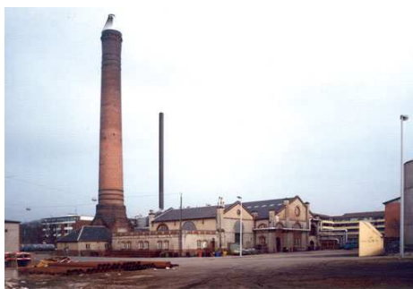
Figur 1.1: Affaldsforbrændingsanlægget på Frederiksberg 1903 med senere tilbygning. På anlægget brændte Frederiksberg Kommunes affald frem til kommunen kom med i I/S Vestforbrændingen og I/S Amagerforbrændingen i 1970'erne. (Danish Board of District Heating, 2006)
