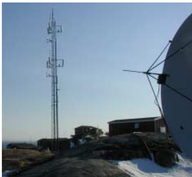
Figur 7.1: TELE Greenlands sendemast og hytte (til højre) i Sisimiut
